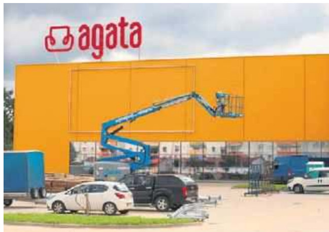
Budowa salonu Agata Meble w Radomiu zbliża się do końca. Trwają prace wykończeniowe wewnątrz.
