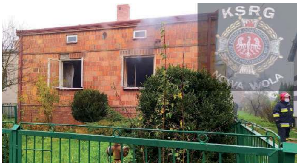
Parterowy, murowany budynek zapalił się wewnątrz
