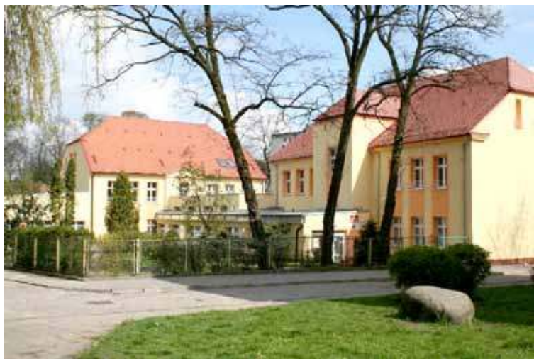
Uczniowie Szkoły Podstawowej Specjalnej mieszczącej się przy ulicy Wita Stwosza będą korzystali z wyremontowanych łazienek i toalet
