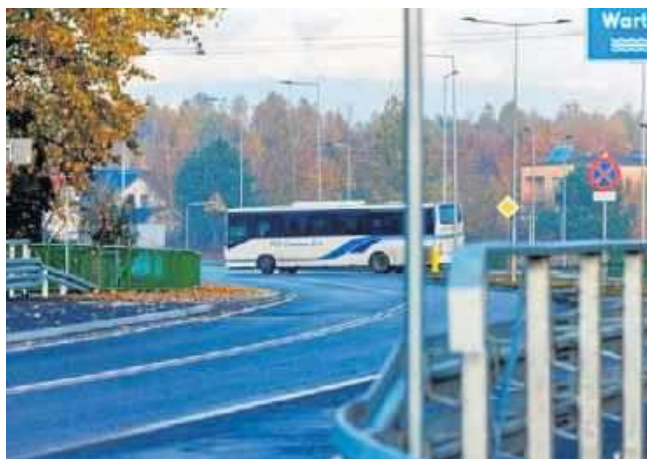
Po remoncie DW 791 ma dwa pasy ruchu o szerokości 3,50 m, z kolei ciągi pieszo-rowerowe mają 2,5 m szerokości
