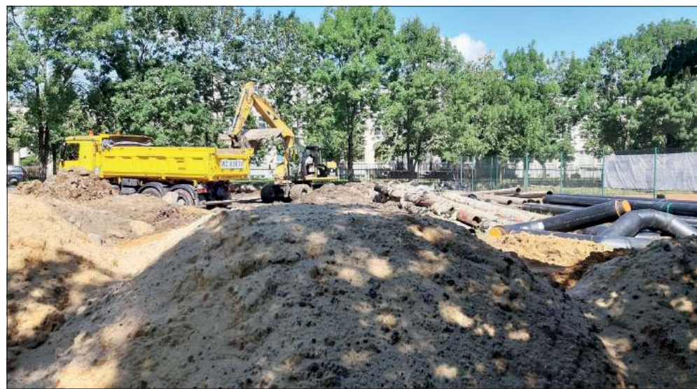
Na zdjęciu widać stare i nowe rury ciepłownicze. Widok od strony SP 15 w Raciborzu.
