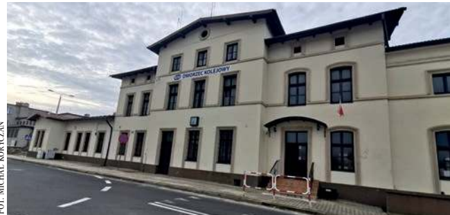
Budynek dworca kolejowego w Trzebini
