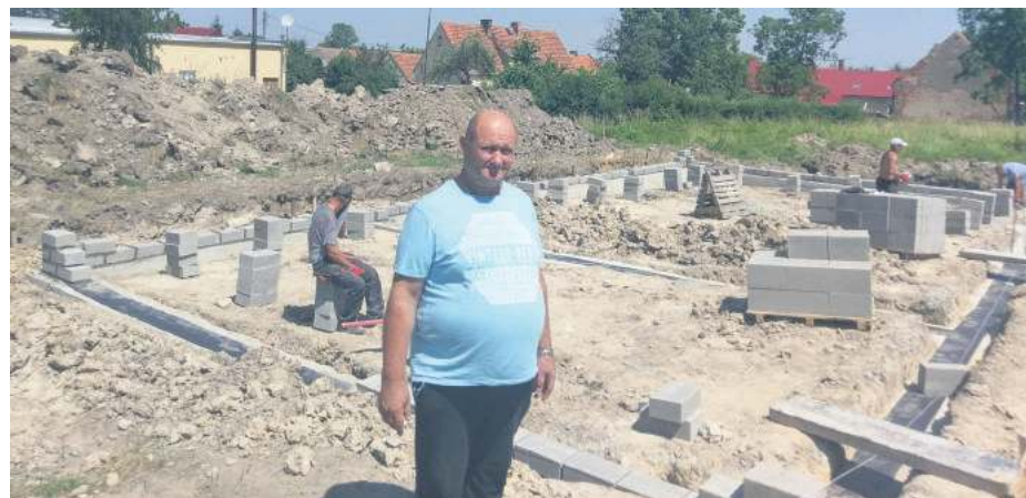
Teren jest obecnie placem budowy. W przyszłym roku powstanie tutaj świetlica. Na zdjęciu sołtys Gościęcic Władysław Białkowski
