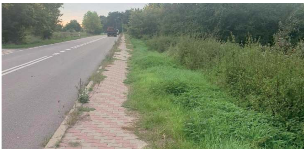
Chodel, ul. Opolska, droga powiatowa. Niedługo chodnika nie będzie już widać. Trwa wdzieranie się coraz mocniej na kostkę brukową
