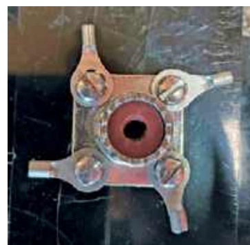
Gniazdko koncentryczne jest umocowane pod skrzyżowaniem płaskowników
