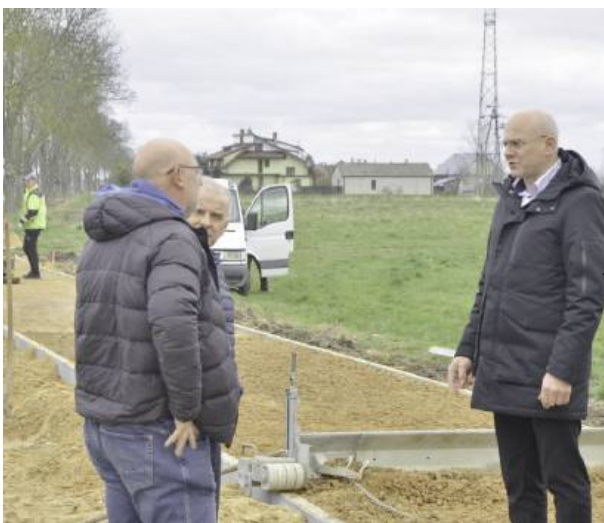
Przebieg prac nad przebudową drogi
