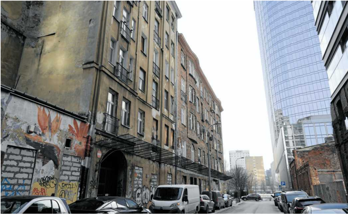
• Niezamieszkałe kamienice przy ul. Waliców FOT. ROBERT KOWALEWSKI / AGENCJA WYBORCZA.PL
