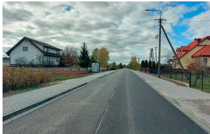
Powiat realizuje mnóstwo inwestycji drogowych. Na zdjęciu zmodernizowany odcinek drogi w m. Syberia (gm. Lubowidz).
