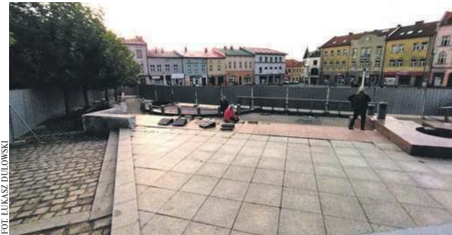
Fragment chrzanowskiego Rynku został ogrodzony jako plac budowy
