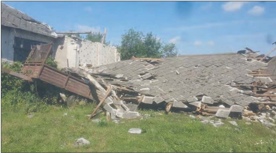
Najbardziej ucierpiały dachy domów i budynków gospodarczych (fot. LUW)
