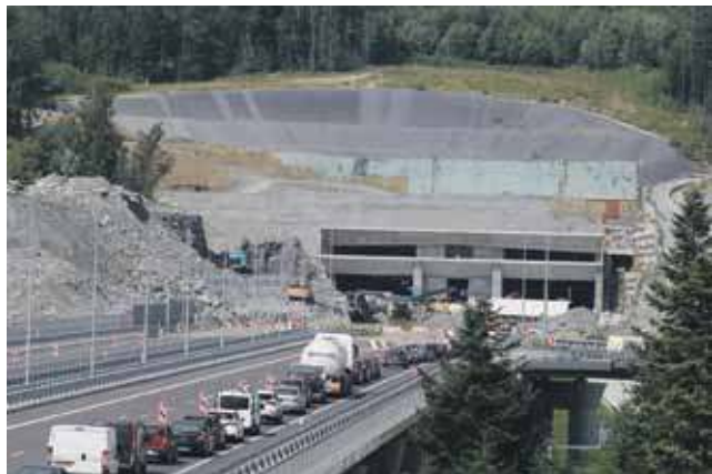
Południowy wlot tunelu
