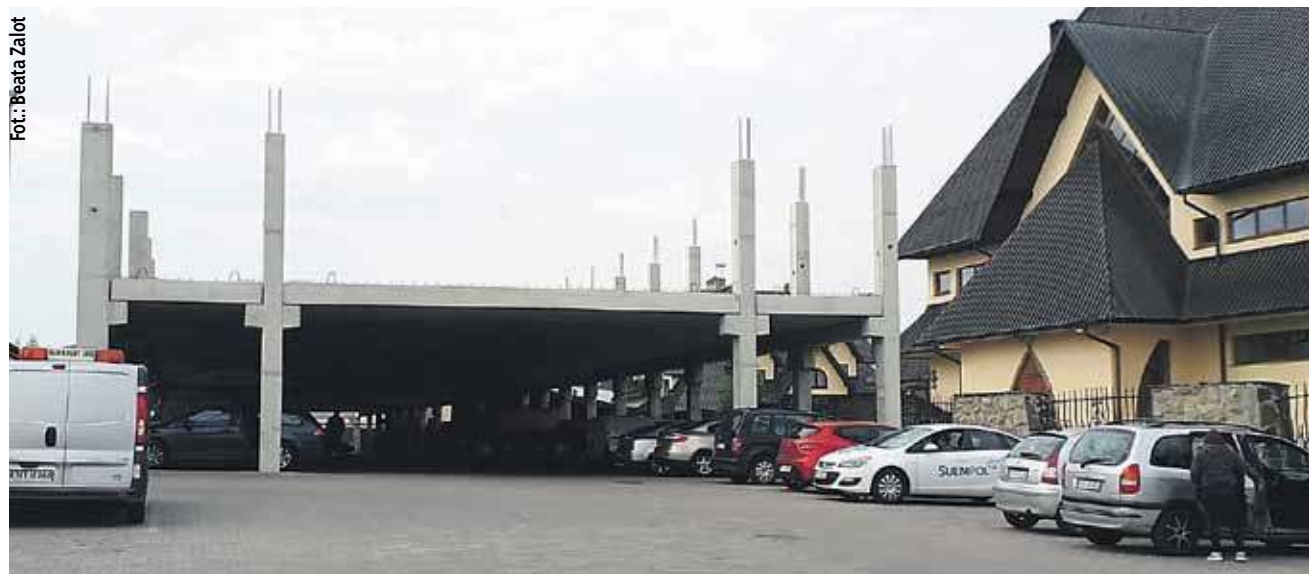
Na dawnym parkingu pomiędzy centrum handlowym Leducer a kościołem Królowej Jadwigi wyrasta betonowy budynek. Jak dowiedzieliśmy się od handlarzy w galerii, trwa rozbudowa Leducera. Na dole będzie zaduszony parking, a na górze stoiska handlowe. Właściciel galerii nie chciał z nami rozmawiać.
