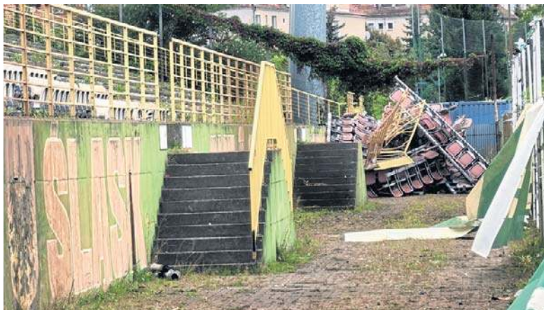
Rozebrana ma być betonowa konstrukcja, a potem wał ziemny
