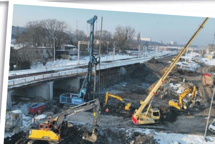
Budowa wiaduktu kolejowego na ul. Szczecińskiej w Słupsku
