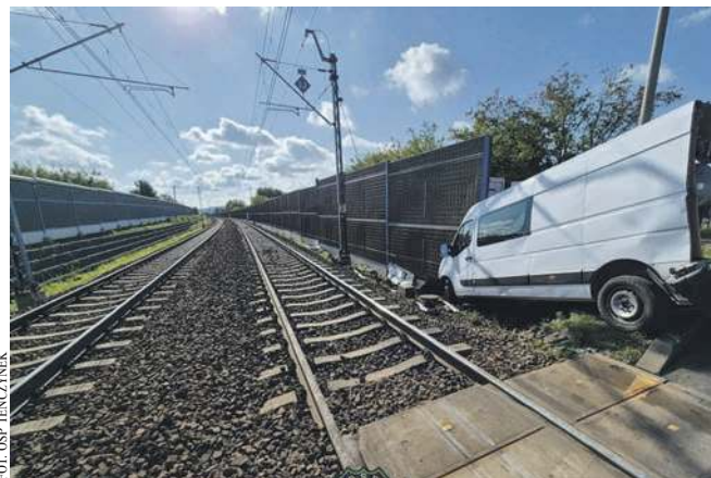
Wypadek na przejeździe kolejowym w Woli Filipowskiej
