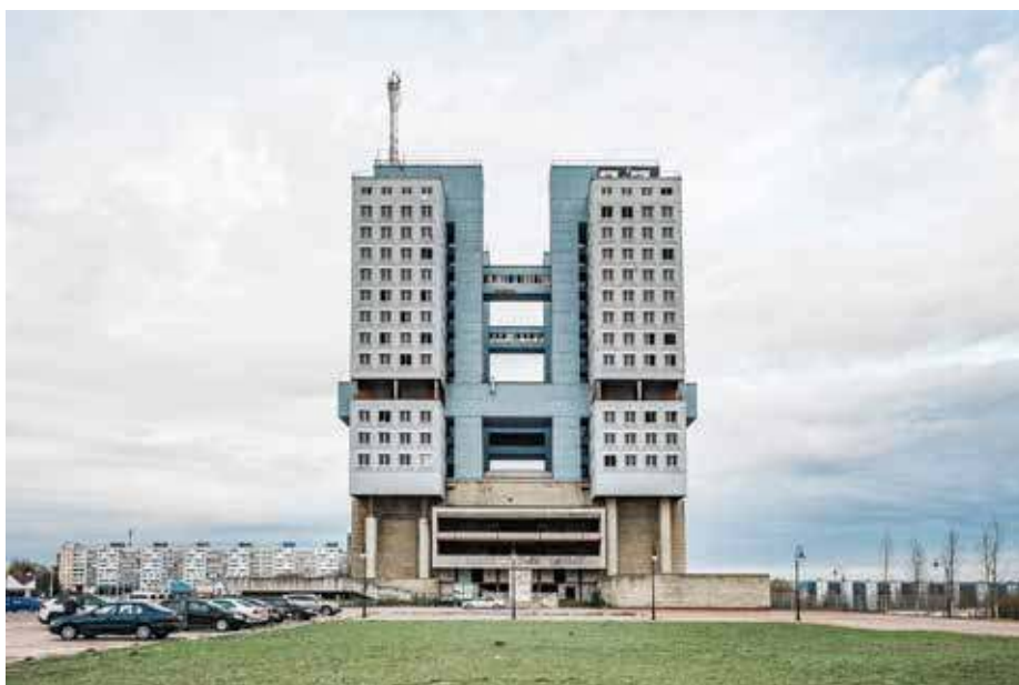
Dom Sowietów w Królewcu to budowla wzniesiona obok miejsca zburzonego królewieckiego zamku krzyżackiego, jako siedziba administracji obwodowej. Dziś opuszczona, trwają dyskusje nad zburzeniem lub rewitalizacją obiektu Fot. Adobe Stock
