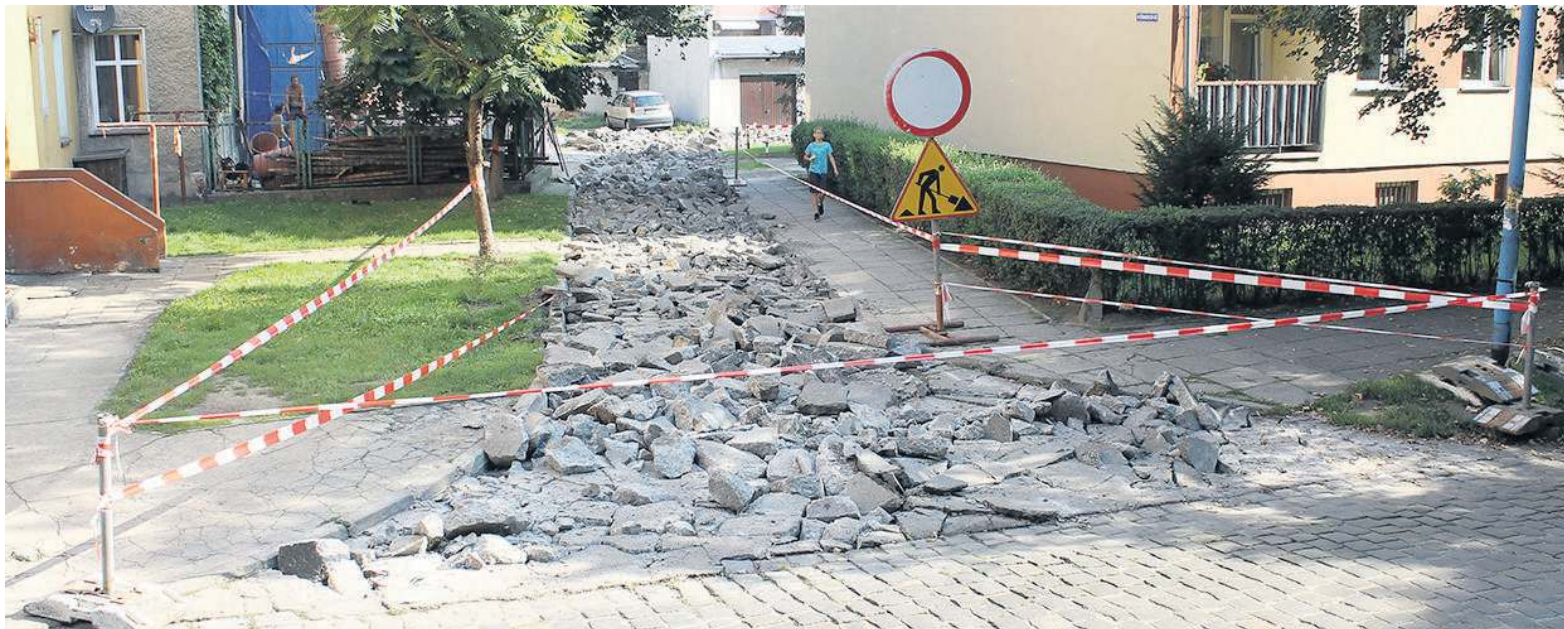
Starą nawierzchnię betonową drogi i chodnika z płyt zastąpi kostka betonowa typu Polbruk
