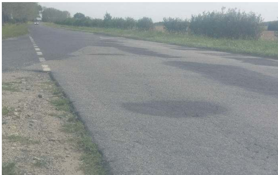
Droga ze Strzelina do Jegłowej już wkrótce zyska nową nawierzchnię
