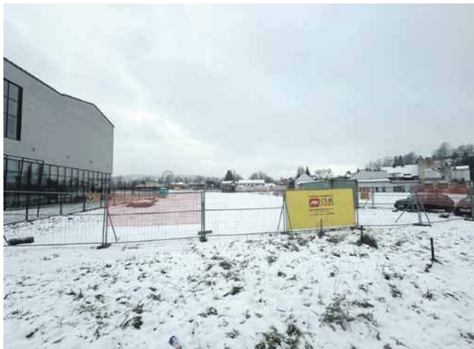
Teren budowy został ogrodzony.
