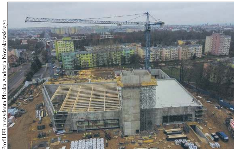
Tak obecnie wygląda budowa aquaparku przy ulicy Miodowej
