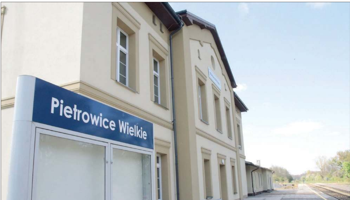
■ Choć nikt o tym głośno nie mówi, to można przypuszczać, że sercem nowo powstałej jednostki stanie się wyremontowany dworzec kolejowy w Pietrowicach Wielkich, gdzie funkcjonuje właśnie Stacja Kultura
