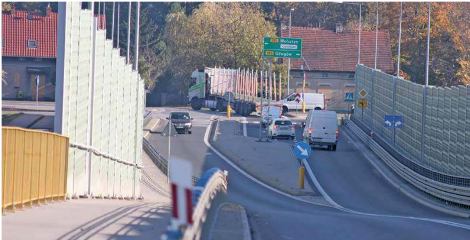
Kwota tej inwestycji była oszacowana na 46 mln zł. Dofinansowanie – 50 proc. – daje 23 mln zł środków rządowych
