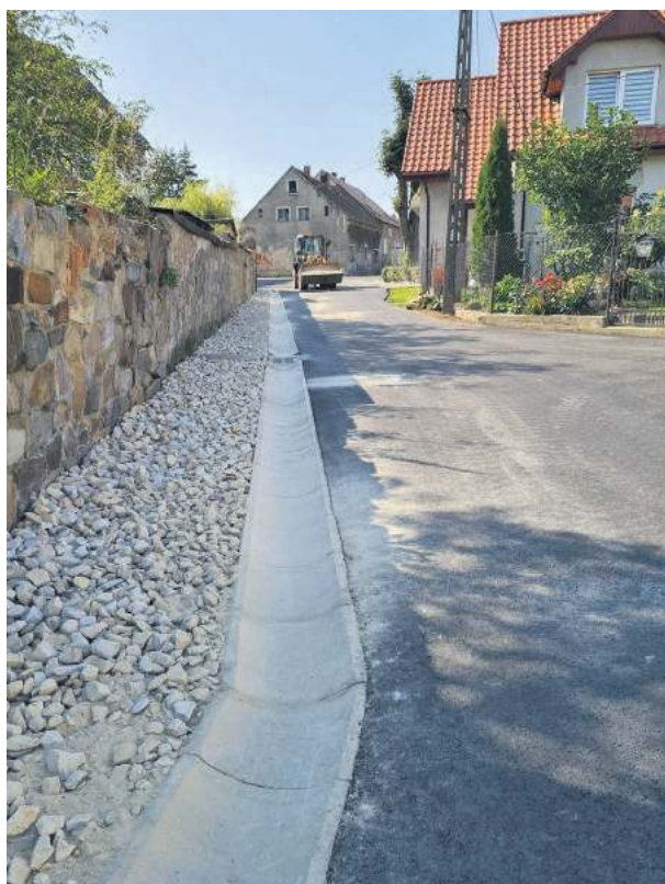
Przy jezdni ułożono korytka ściekowe
