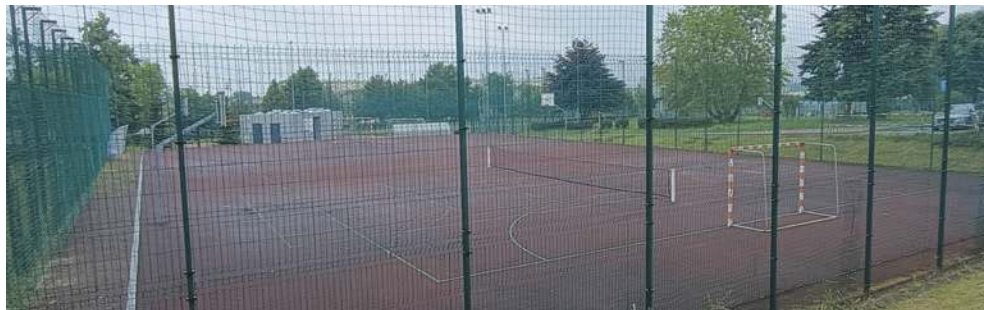
Orlik na osiedlu Północ przed modernizacją
