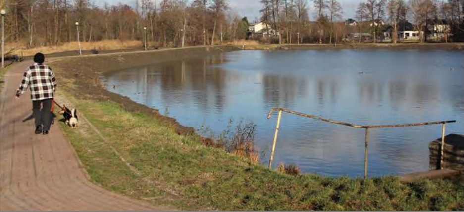
Dobiegły końca prace przy odmulaniu stawu Skalski
