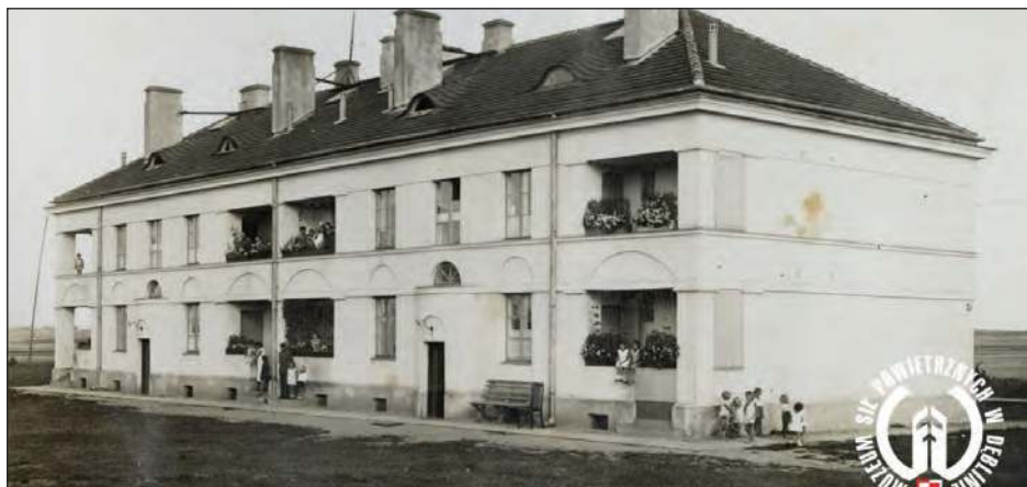
■ Dom mieszkalny dla majstrów nr 39 przy ul. Lotniczej.
