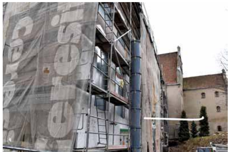
Na ścianach zewnętrznych wykonywana jest izolacja termiczna
