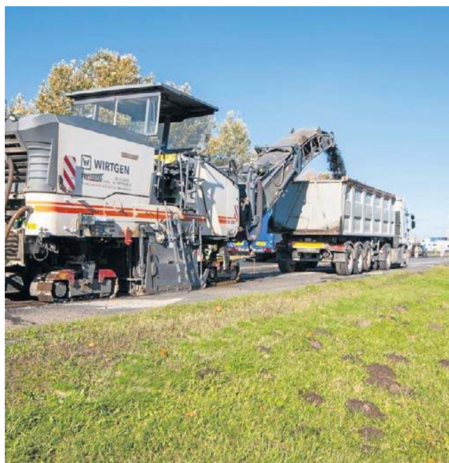
Prace w pierwszej części prowadzone są na jezdni w kierunku centrum miasta na odcinku przy lotnisku
