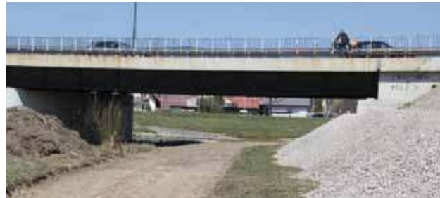
Powstający odcinek Velo Dunajec pod mostem na al. Tysiąclecia.
