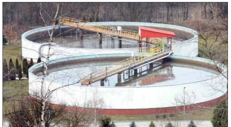
Reaktory rabczańskiej oczyszczalni ścieków,
