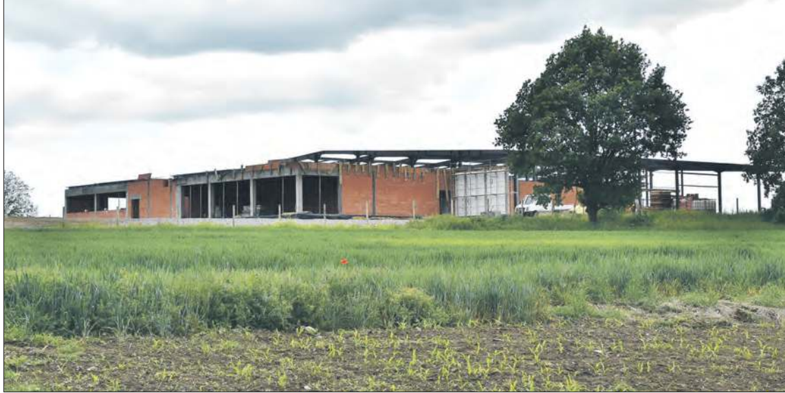
Fabryka Wood od Fire w Prudniku w budowie
