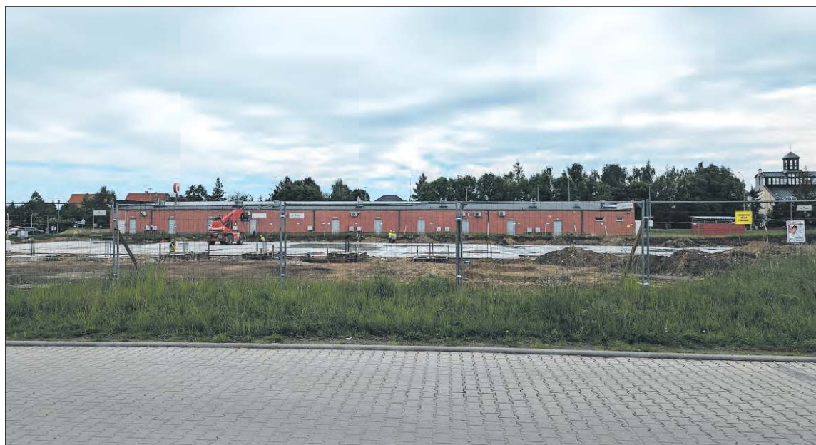
Fundamenty pasażu przy Czerwonej Torebce
