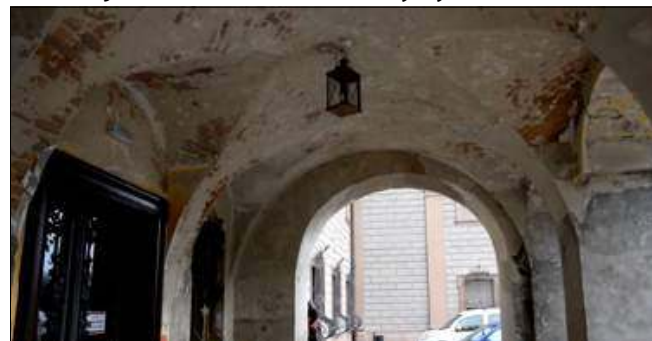
Trwa remont podcieni.
