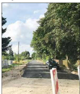
Trwa budowa drogi w Woli Dubowskiej
