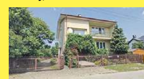
Dwupiętrowy dom w Białej Podlaskiej, przy ulicy Maciąga, 885 851 172
