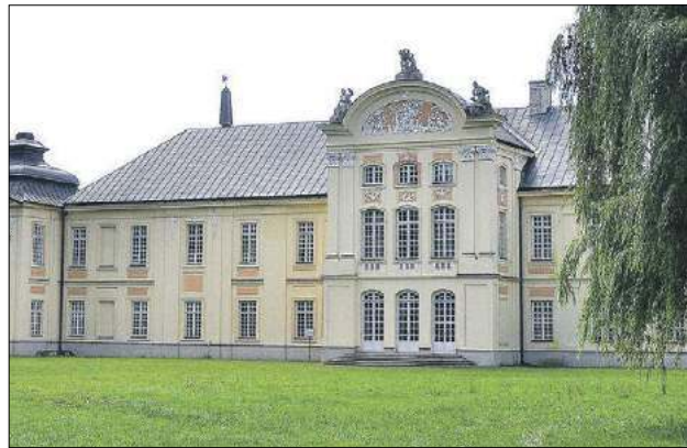
Fasada północna pałacu była zrewitalizowana w 2008 roku. Teraz miasto robi to powtórnie
