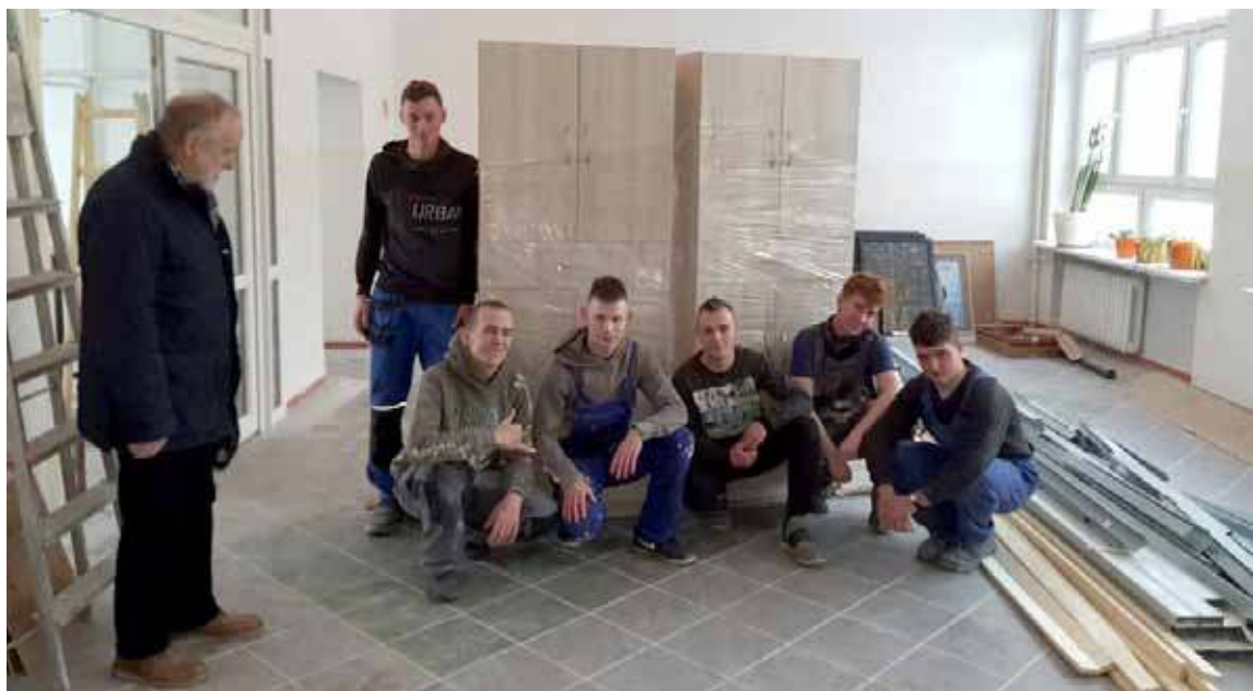
Uczniowie w ramach praktyk zawodowych przeprowadzili remont pomieszczeń w budynku przy ulicy Ceglanej
