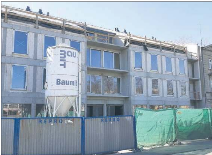
Trwa odbudowa kamienicy przy ul. Królewieckiej 18
