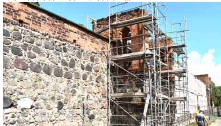
Wzmocniona będzie korona muru, a całość zyska zabezpieczenie przed niekorzystnymi warunkami atmosferycznymi
