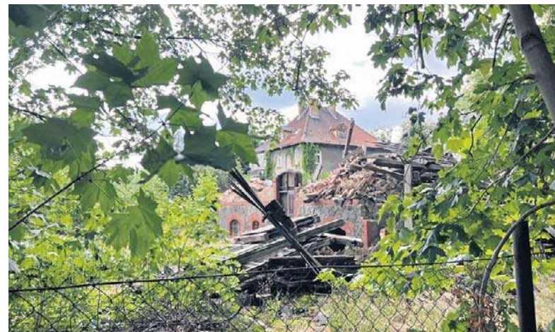
Zabytkowa willa została zdemolowana w marcu 2024 r. Tak wygląda obecnie (lipiec 2026 r.).
