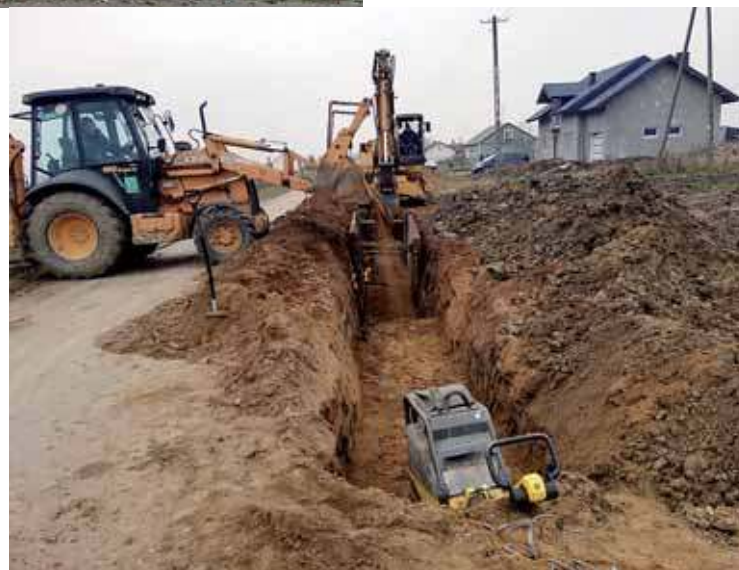
Budowa kanalizacji w Karwaczu
