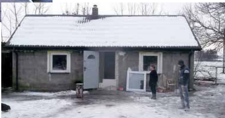
Ten dom po odbudowie
