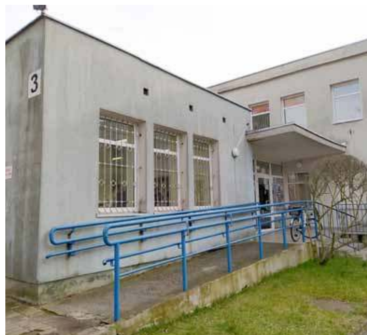
Wypożyczalnia zorganizowana została w budynku RCP przy ul. Wojska Polskiego
