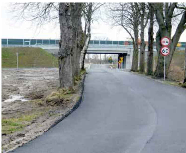
Na drodze została położona nowa nakładka bitumiczna
