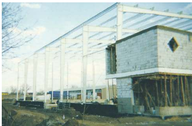
Budowa hurtowni przy ul. Paprotnej we Wrocławiu
