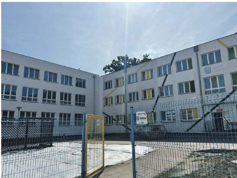
Nowe skrzydło szkoły jest już wykonane, ale nie ma w nim toalet czy osobnego wyjścia ewakuacyjnego. Ale to nie wszystko...
