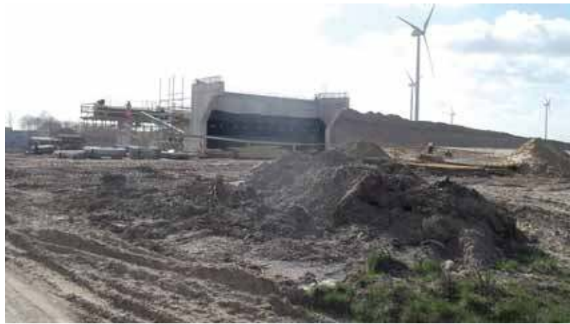
Budowa wiaduktu w okolicy Wiśniewa
