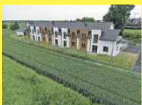
2 segmenty w nowocześnie zabudowie szeregowej, w stanie deweloperskim w Łukowie przy ul. Gospodarskiej, 885 851 158
