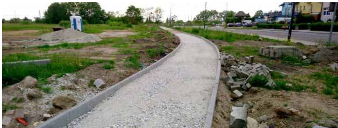
Trwa budowa ścieżki rowerowej wzdłuż ulicy Armii Krajowej
