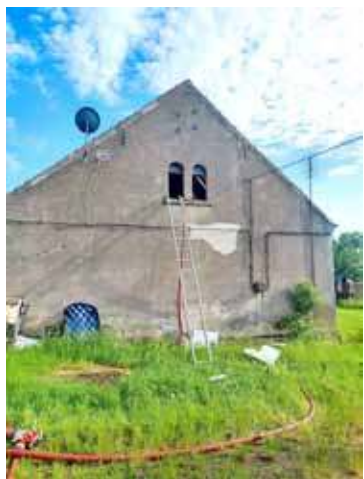
W minioną sobotę strażacy gasili pożar poddasza w budynku wielorodzinnym w Wapnicy. Foto. OSP. Dobrzany
