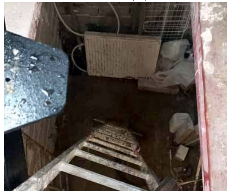
W miniony czwartek strażacy odebrali dwa zgłoszenia dotyczące zalanych piwnic na ul. Armii Krajowej i Krzywej. Foto. OSP. Ińsko
