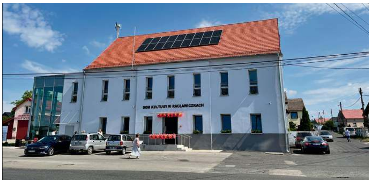
Na dachu budynku zamontowano panele fotowoltaiczne.
