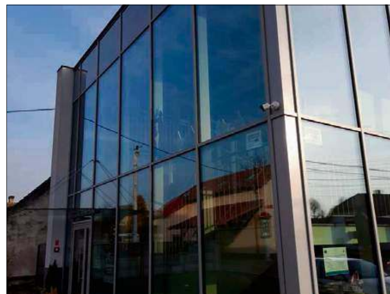
Zastosowane w przybudówce szkło pomaga dodatkowo nagrzewać budynek.
