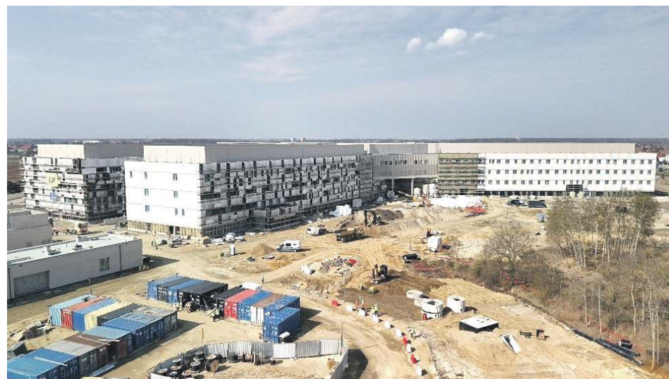
Budowa Nowego Szpitala Onkologicznego idzie pełną parą
