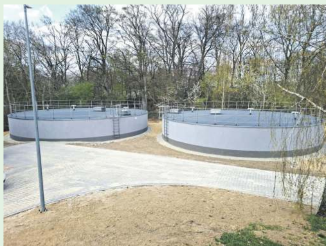
Ukończona budowa dwóch zbiorników wody w Machnicach
