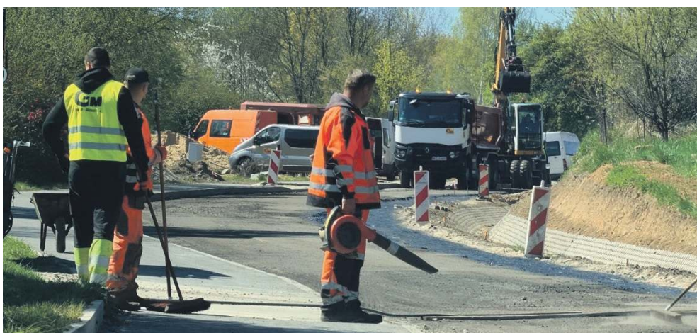
Trwają intensywne prace
