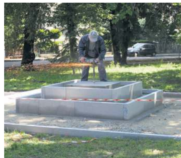
Za przygotowanie podstawy pomnika odpowiedzialni byli pracownicy Centrum Usług Komunalnych i Technicznych w Strzelinie
