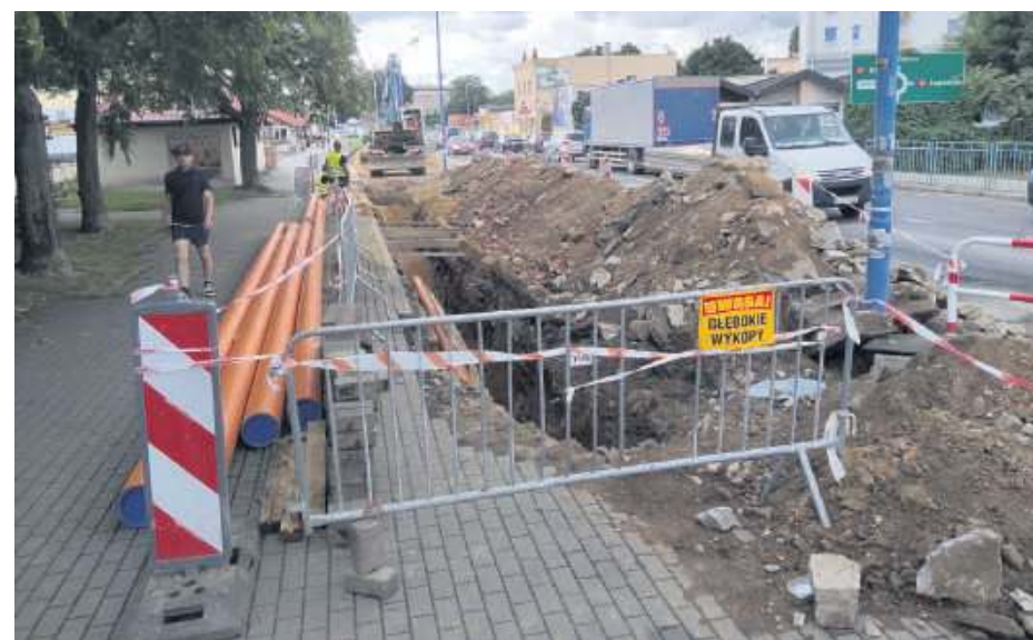
Od kilkunastu dni na ulicy Wolności w Strzelinie trwają prace ziemne związane z modernizacją tej drogi
