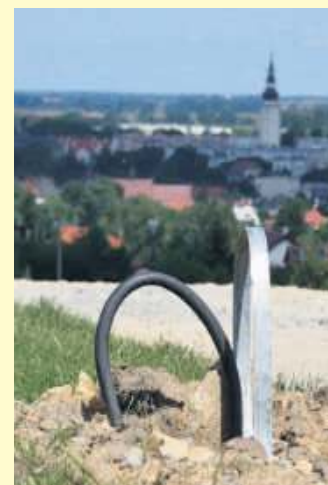
W ubiegłym tygodniu ruszyły prace ziemne związane z budową oświetlenia drogowego na ulicy Sosnowej w Gęsińcu
