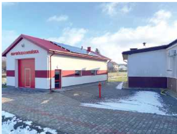
W Wólce Łabuńskiej wybudowano nowe utwardzenie między remizą a świetlicą, a za nimi - mały plac zabaw
