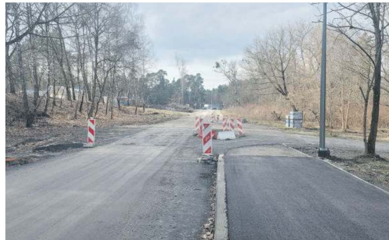
Planowany termin zakończenia robót to 16 sierpnia 2024 r.
