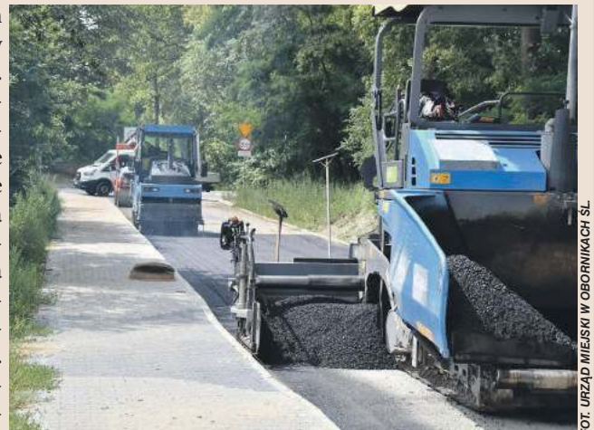
Kładzenie nawierzchni asfaltowej na ul. Paderewskiego w Obornikach Śl.
