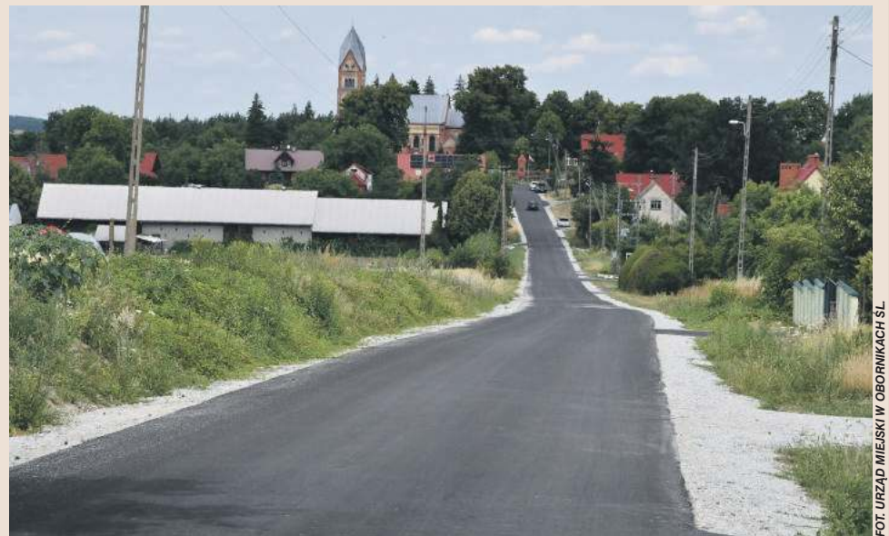
Ulica Kalinowa w Bagnie. Dotąd po przejechaniu samochodu wznosiły się tumany kurzu opadające na przylegających posesjach. Teraz ma nową nawierzchnię asfaltową.
