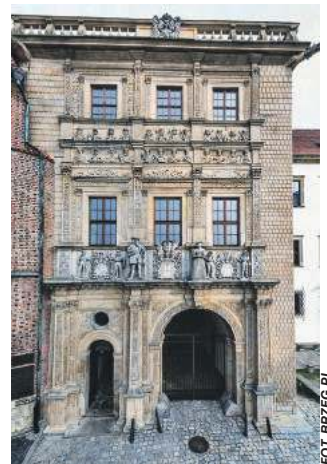
Bogato rzeźbiona fasada budynku brannego Zamku Piastów Śląskich
